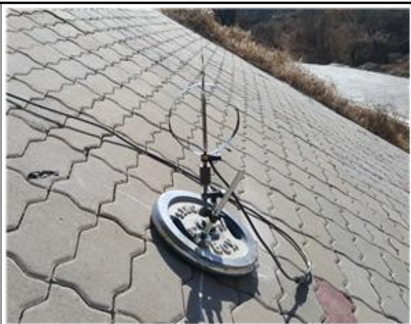
처짐계 설치 현황
