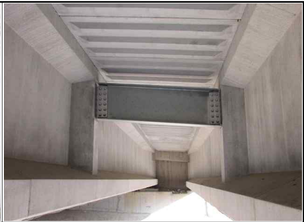
강재 가로보 상태양호
