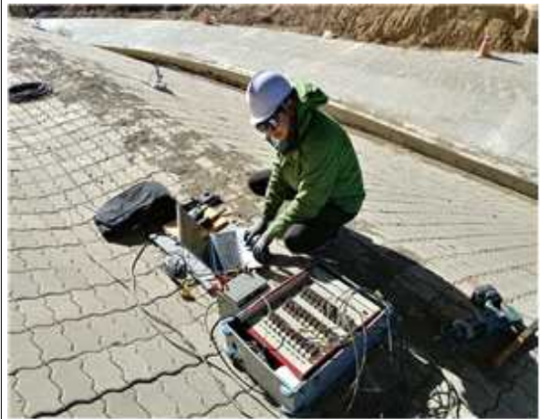
재하시험 계측 전경
