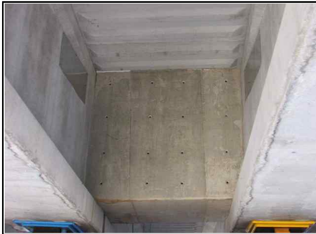
콘크리트 가로보 상태양호
