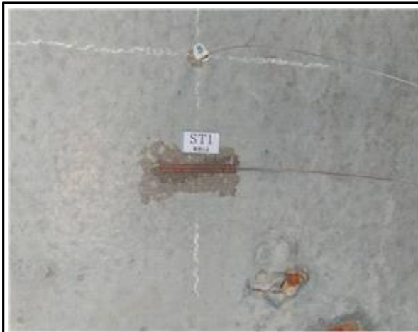
변형률계 설치 현황
